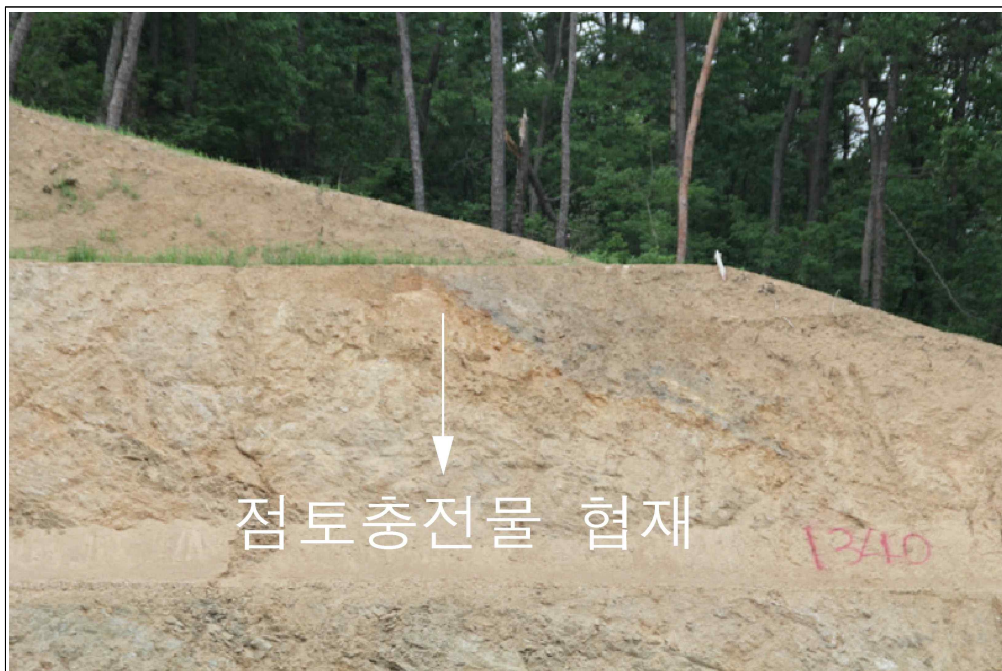
【그림 17】 C 영역 상세사진 (차별풍화 발생 구간)
