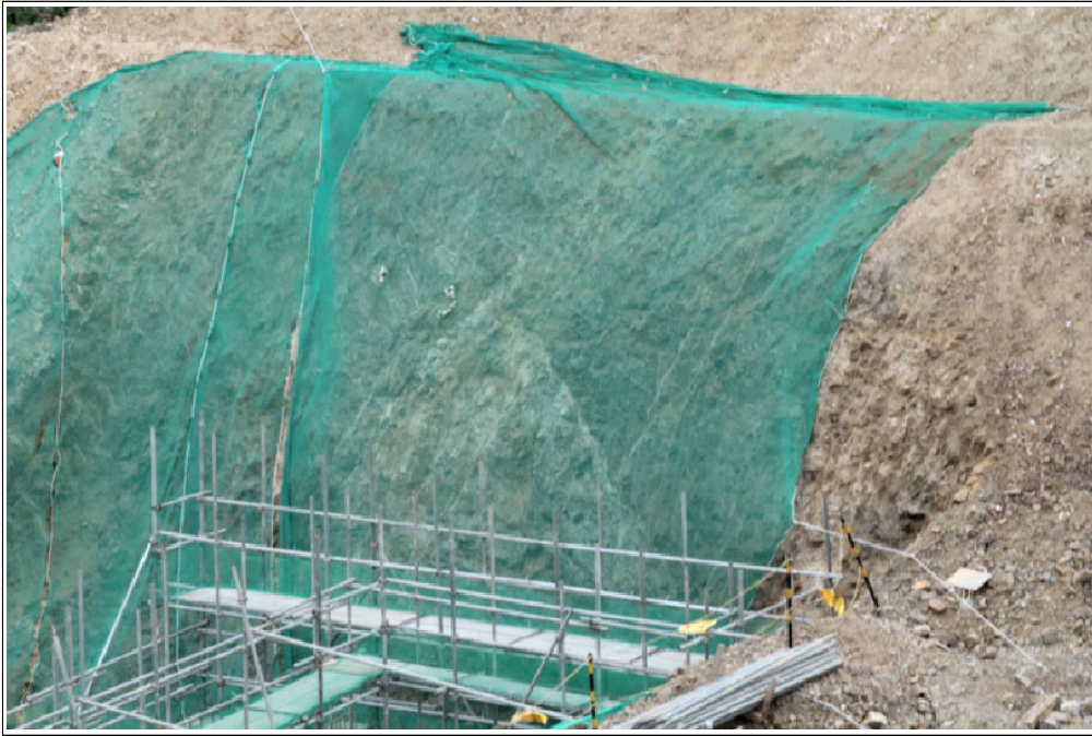
【그림 12】 A 영역 상세사진 (세편화된 암석)
