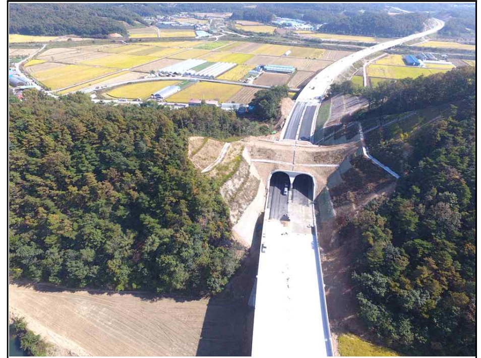
【그림 4】 깎기비탈면 종점부 측면 사진
