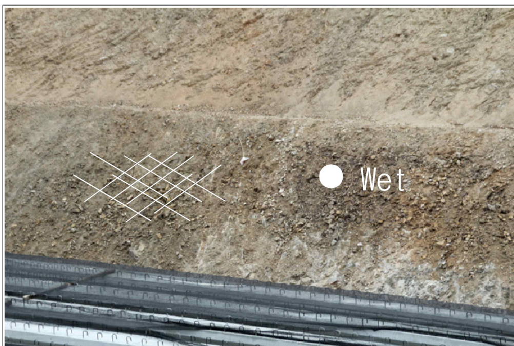
【그림 14】 B 영역 상세사진 (지하수 유출 및 세편화된 암석)
