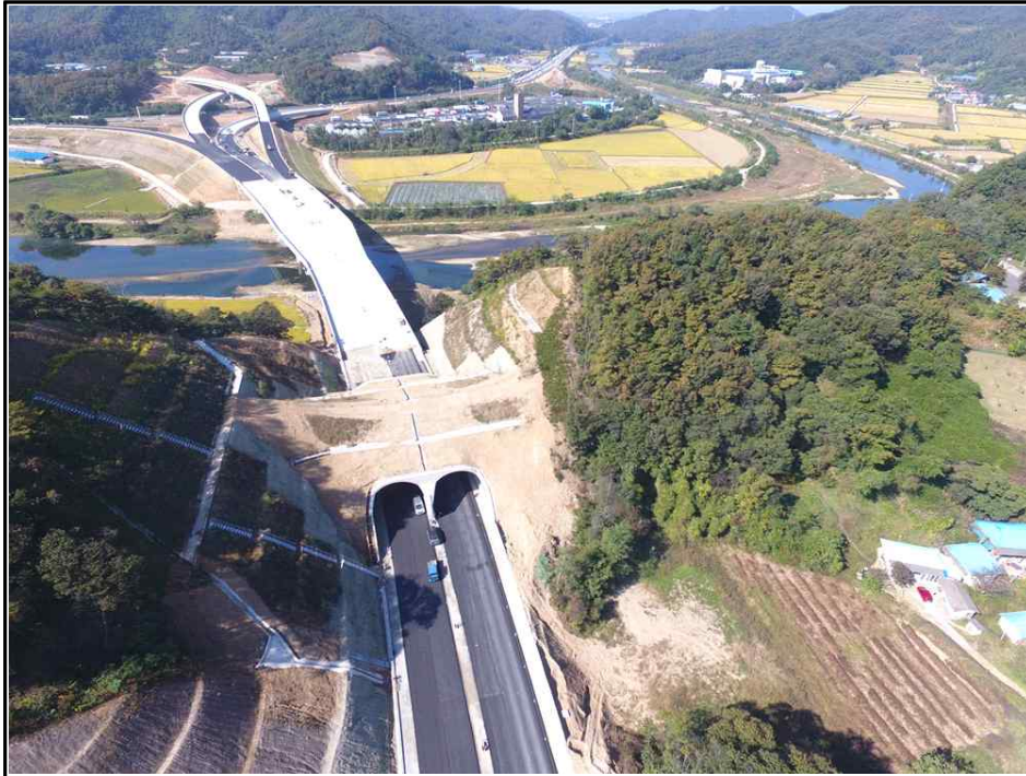
【그림 3】 깎기비탈면 시점부 측면 사진
